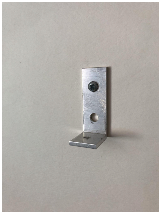
Imagen N° 75, ejemplo de sujeción perfil de acero con forma de L. Fotografía de la autora.
