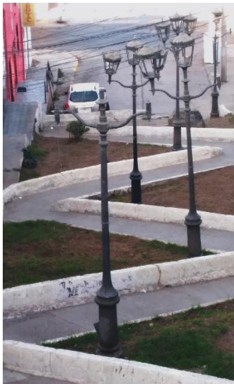
Luminaria mal estado
