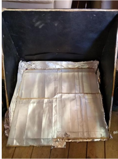
Imagen 6: Proceso de forrado con tetrapack
