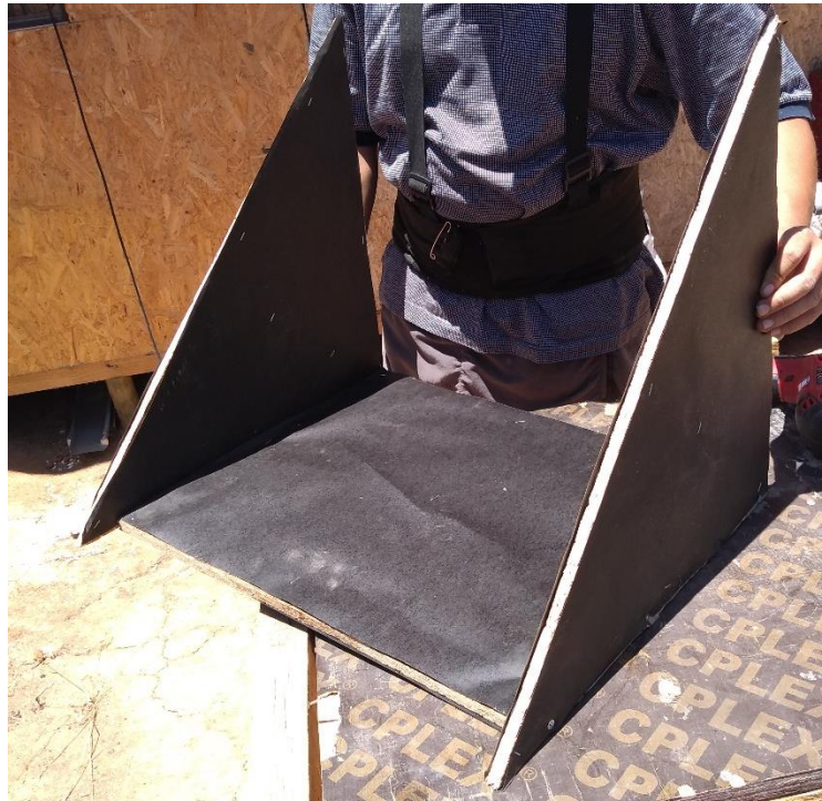
Imagen 5: Inicio de montaje
