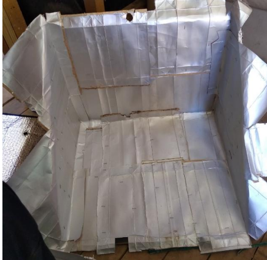
Imagen 7: Segunda capa de aislante
