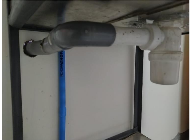
Figura 6. Tubería de desagüe. Fuente: Elaboración propia.
