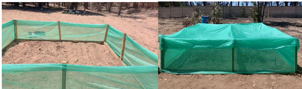
Figura 20: Instalación malla raschel perimetral y cubierta superior en Círculo de Inclusión Los Maitenes, Puchuncaví.
