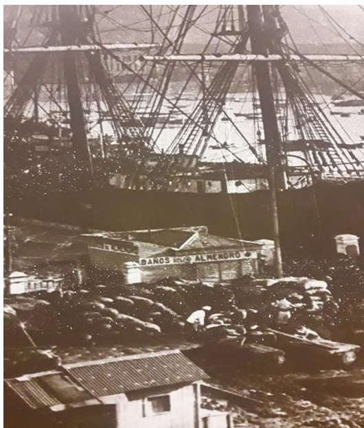
Fig.Nº2. Infraestructura de baños públicos de mar en casetas
