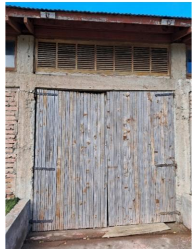
Figura 2 Bodegas portuarias, detalle.
