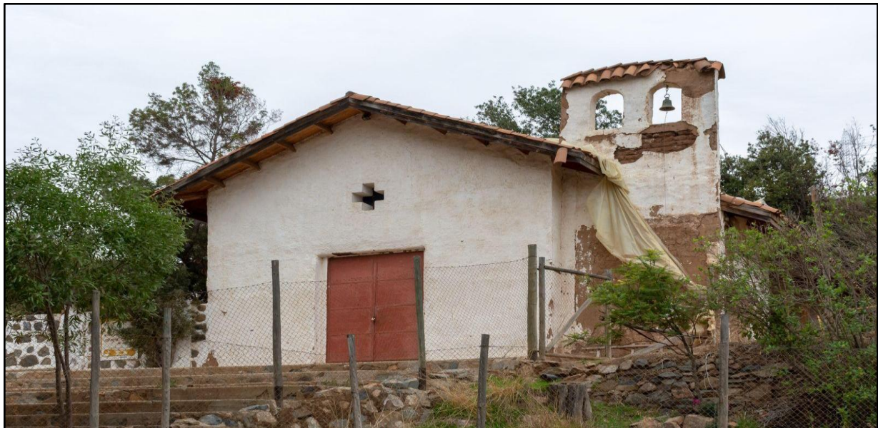
Figura N°7: Capilla de La Dormida
