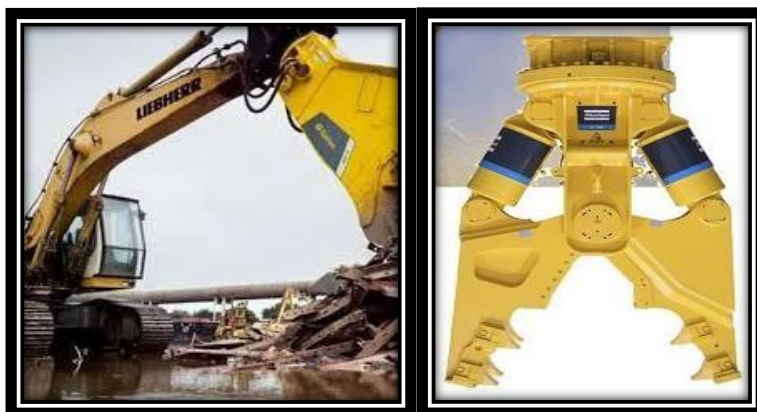
Figura 9. Retroexcavadora utilizando cizalla.
