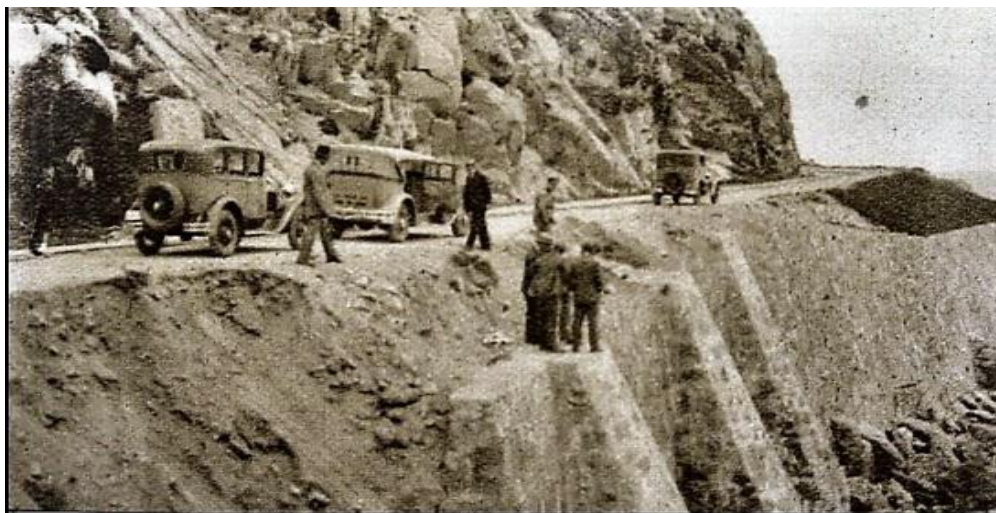
Imagen 25. Construcción Camino Costero, fotografía. Fuente Boletín de Caminos, 1927.
