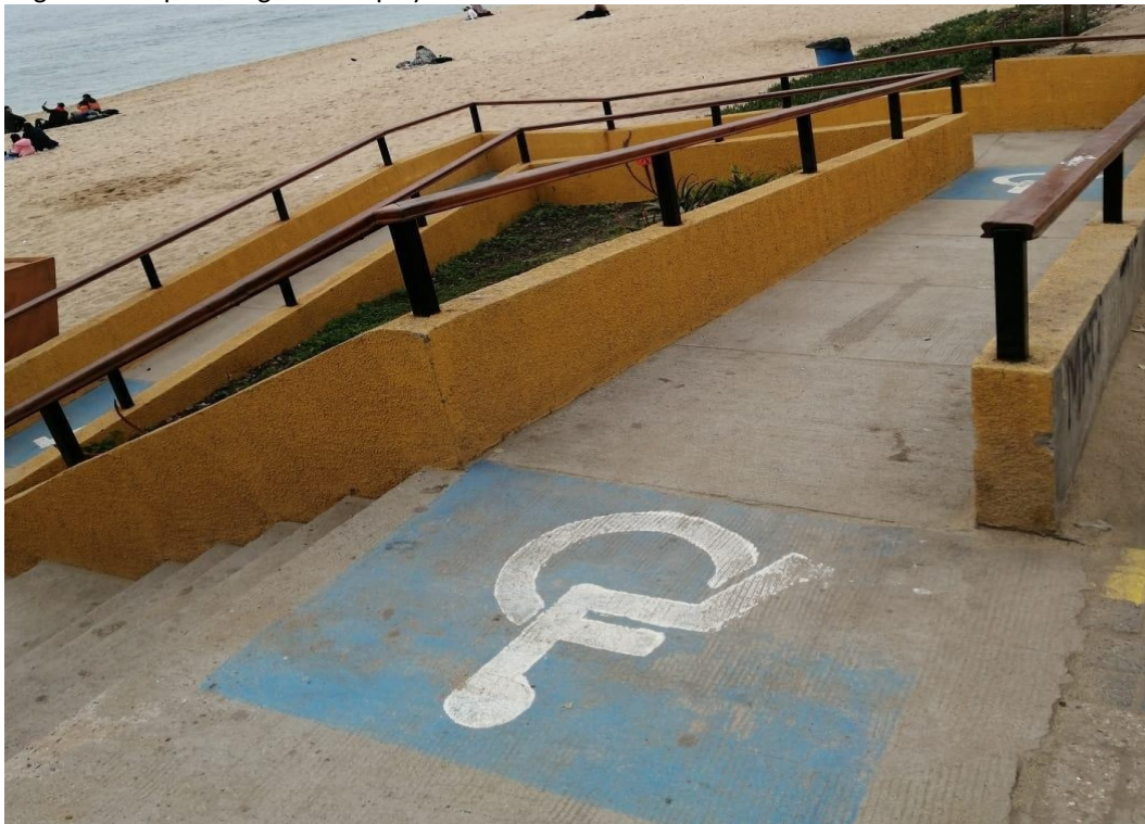
Fig. 33: Rampa de ingreso a la playa el Sol
