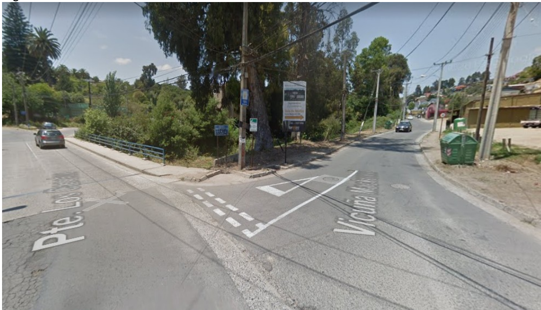
Fig. 112: Ubicación en Vicuña Mackenna con el Puente Los Canelos
